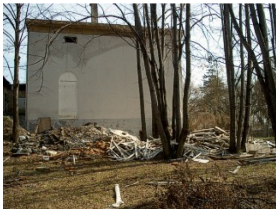
Posesja prywatna w trakcie remontu, ul. Okrzei
