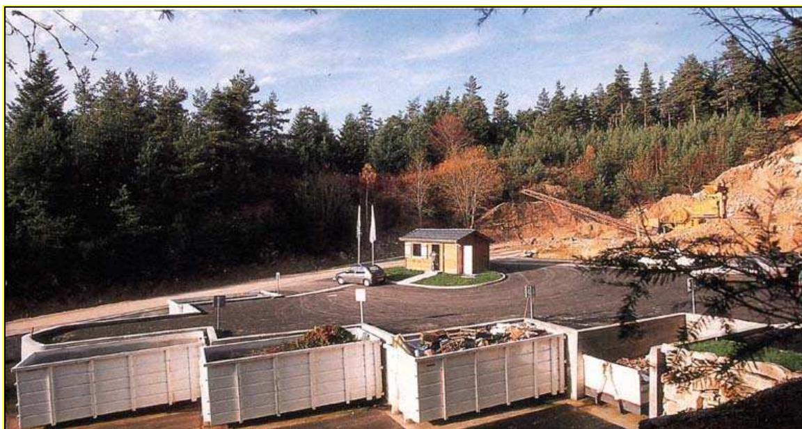
Fot. 6.3. Elementy Punktu Dobrowolnego Gromadzenia Odpadów (PDGO) (Plan gospodarki odpadami dla woj. dolnośląskiego, 2004)
