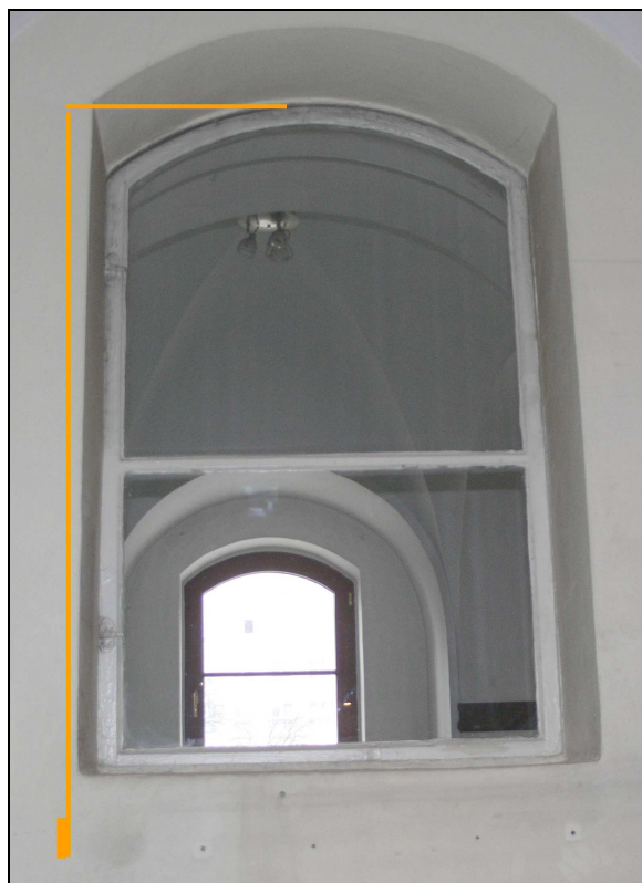
Zdjęcie nr 18. Okno nr 045. Widok od strony portierni. Okno uchylne z uchwytem otwieranym po stronie lewej jak widać na zdjęciu.
